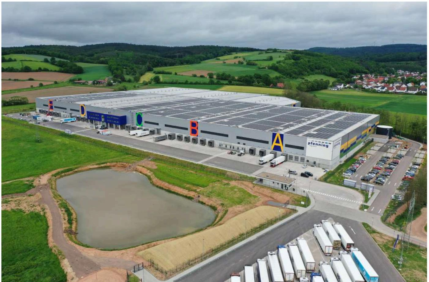
Das neue Multicube Osthessen: Eine Aufdach-Photovoltaikanlage mit knapp 24.000 Solarmodulen auf etwa 50.000 Quadratmetern Fläche sorg künftig für die Produktion von grünem Strom. (Foto: Nestlé)
